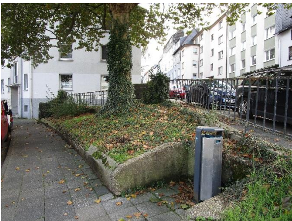
Abbildung 7: Bestandssituation an der Grünfläche Krautstraße/Hebbelstraße
